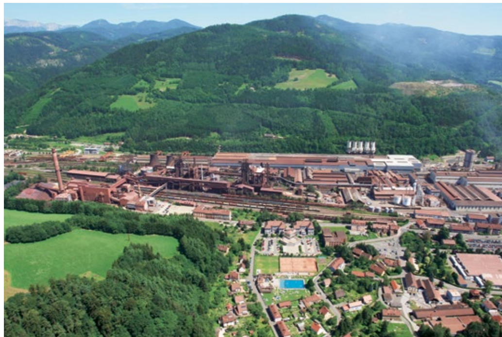
Luftbild vom Werk der voestalpine im Stadtteil Donawitz
