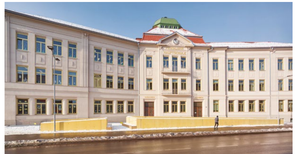
Spuren der Vergangenheit: Die bestehende Eingangssituation mit den Originalportalen ist für repräsentative Situationen wie Schulfeste weiterhin in Verwendung. Die neuen Fensterprofile übernehmen den bronzenen Ton der Originalschriftzüge an der Fassade.
