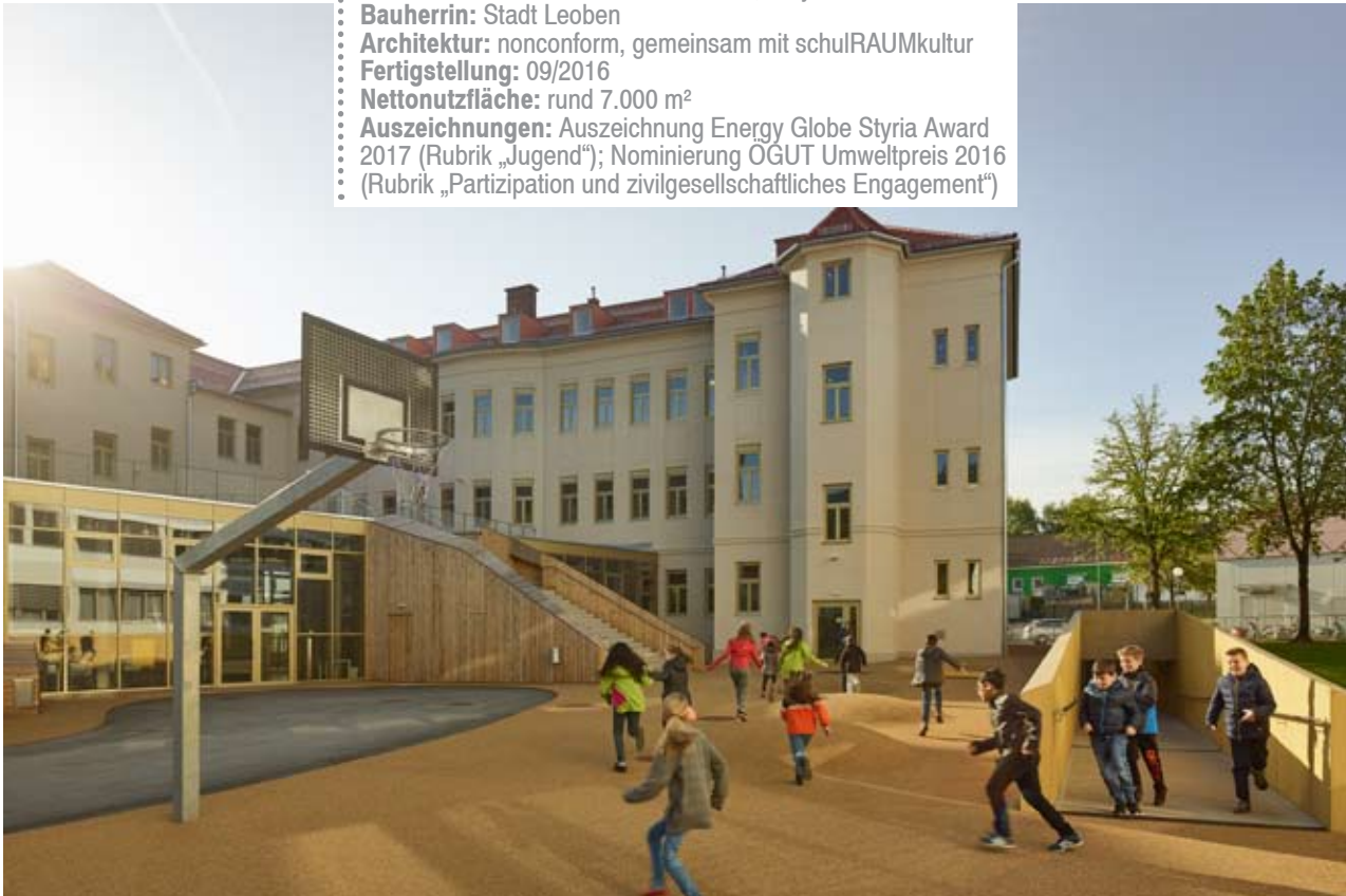
9 Außenansicht Bildungszentrum Pestalozzi; Foto: Kurt Hörbst
