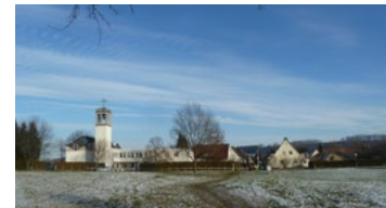
7.2.1 Blick von Westen Richtung Haupteingang
