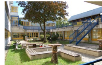
7.1.1 Innenhof mit Blick auf Turnsaal
