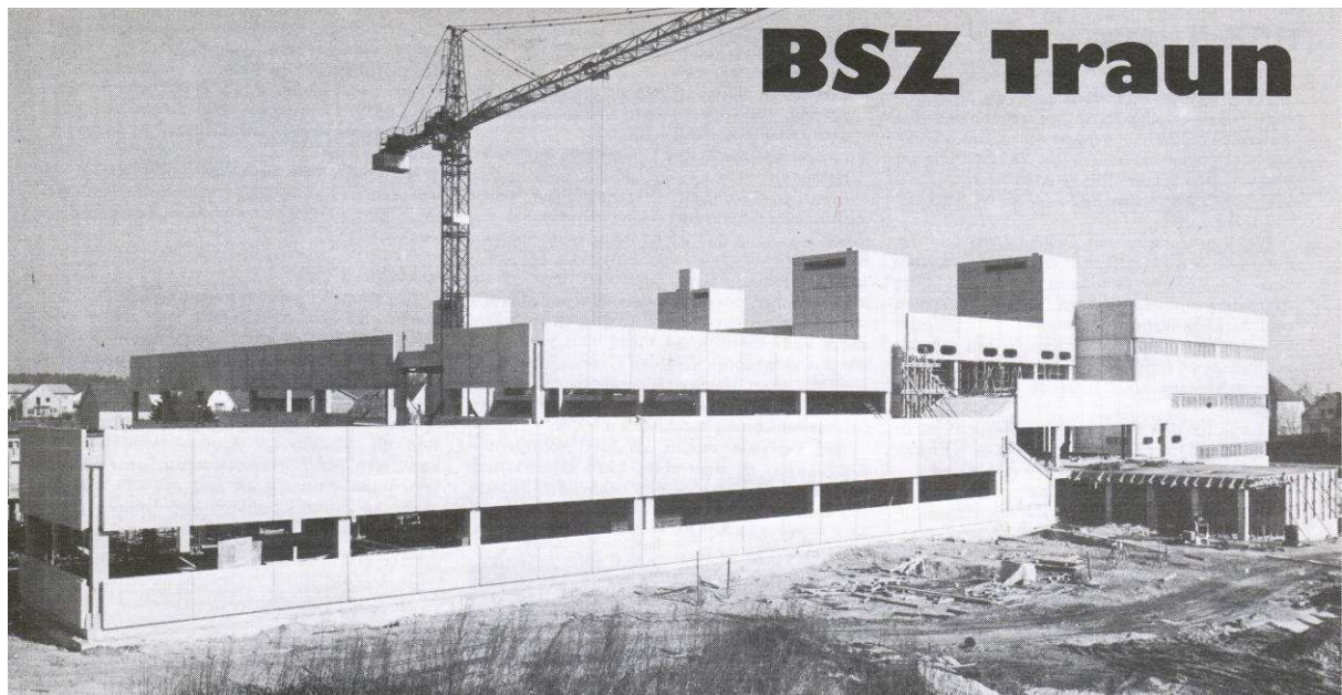
Abbildung 14: Die Baustelle des BSZ Traun von Südwesten aus 64
