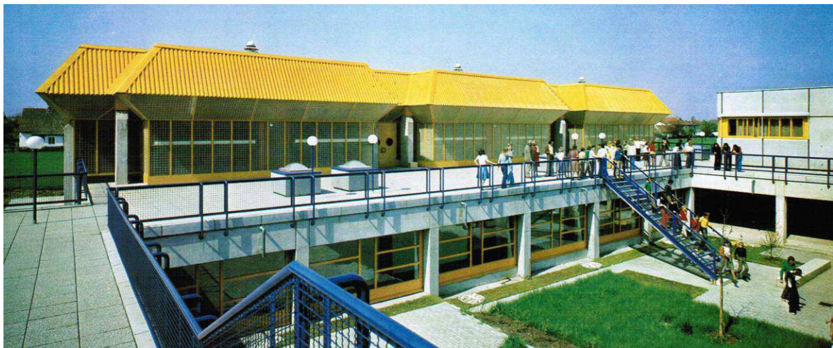
Abbildung 20: Blick über den Werkhof zum Turnsaalgebäude Richtung Süden 83
